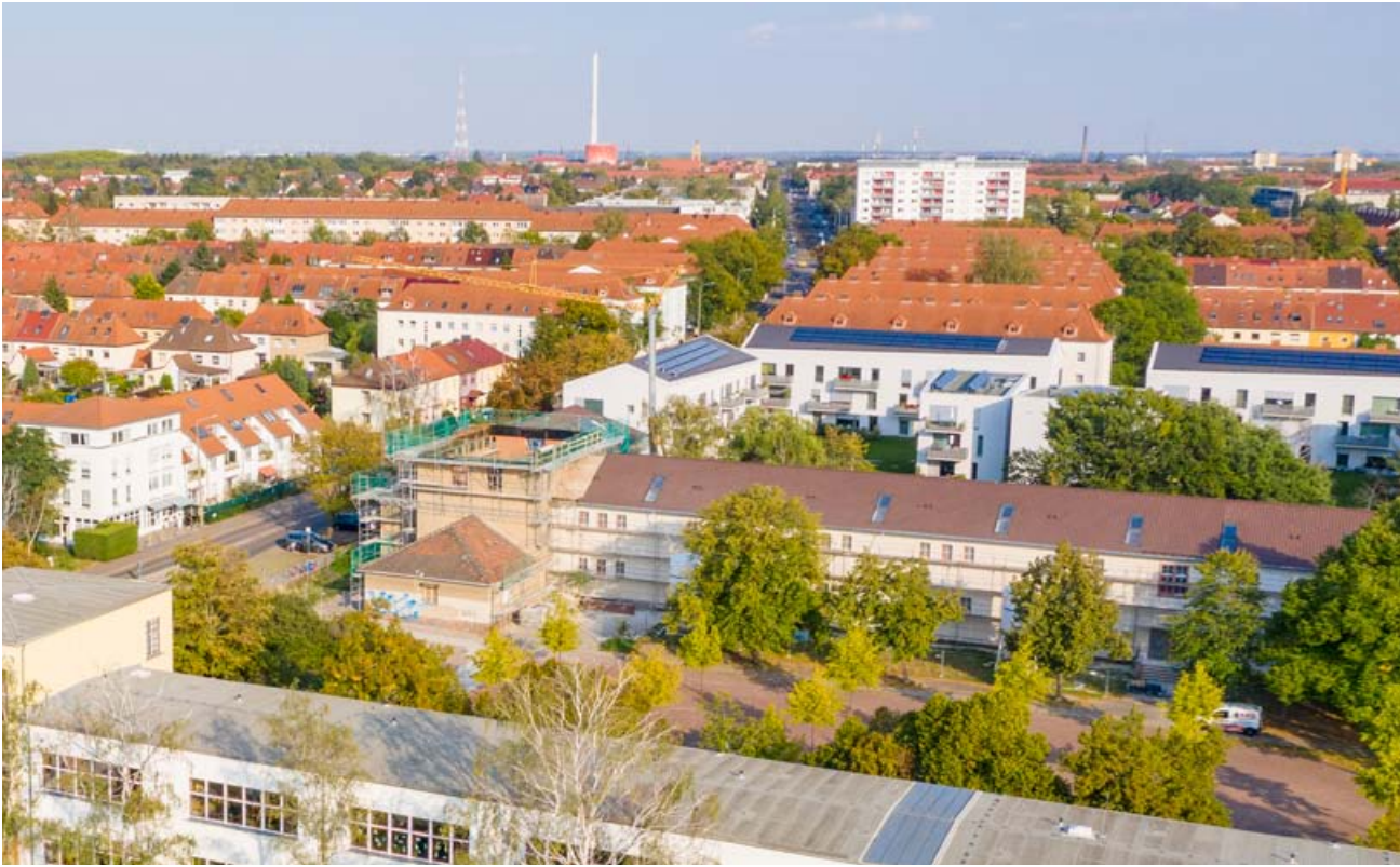
Das aktuelle Sanierungsprojekt „Wohnen in der alten Schule“ der GWG „Eigene Scholle“ eG befindet sich auf der Zielgeraden. Mittlerweile ist das Dach fertiggestellt und der Innenausbau ist in vollem Gange.
