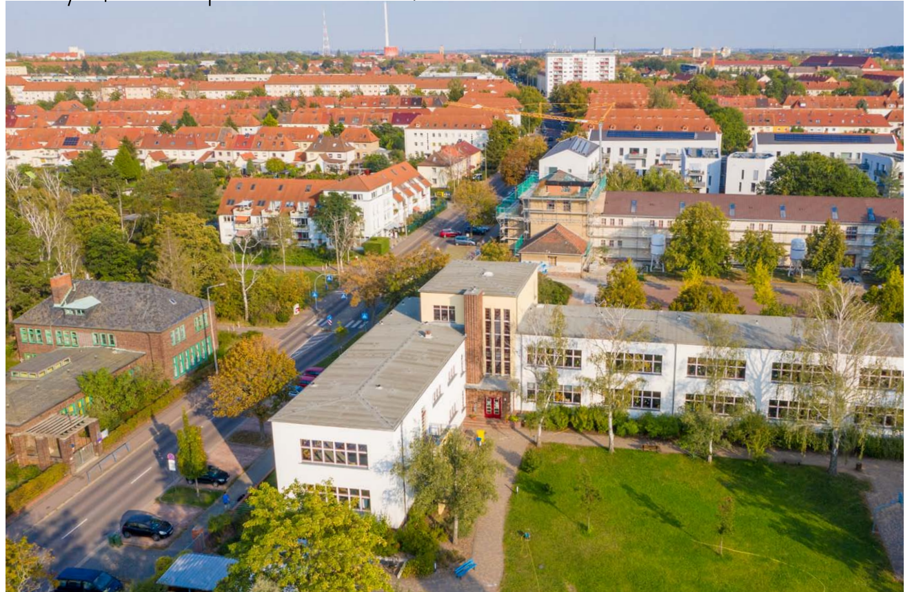
Beide Schulgebäude (ehem. Reichweingymnasium – eingerüstet – und Diesterwegschule vorne im Bild) waren Bestandteil einer monumentalen Platzanlage mit großer Kirche (nicht realisiert) und Kirchensaal (li.) als Zentrum der Gartenstadt Gesundbrunnen.
