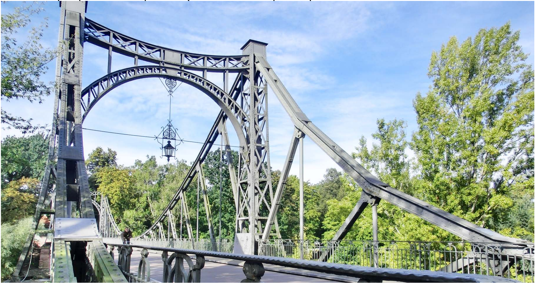
Von vielen auch „Peißnitzbrücke“ genannt, ist die 103 Meter lange „Brücke der Freundschaft“ die beliebteste Verbindung für Fußgänger und Fahrradfahrer von der Peißnitzinsel zur Ziegelwiese.
