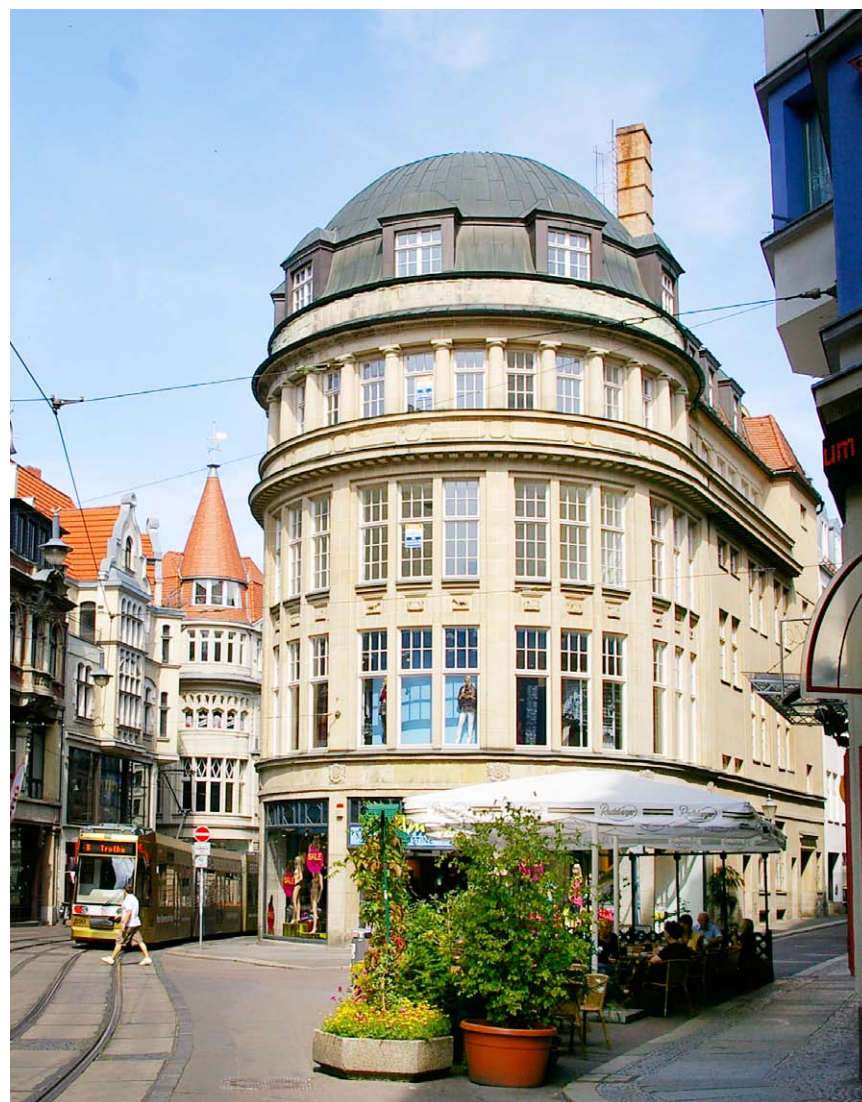
Der neoklassizistische Kaufhausbau mit Kuppel und streng gegliederter Rasterfassade charakterisiert die Große Ulrichstraße wie kaum ein anderes Gebäude.
