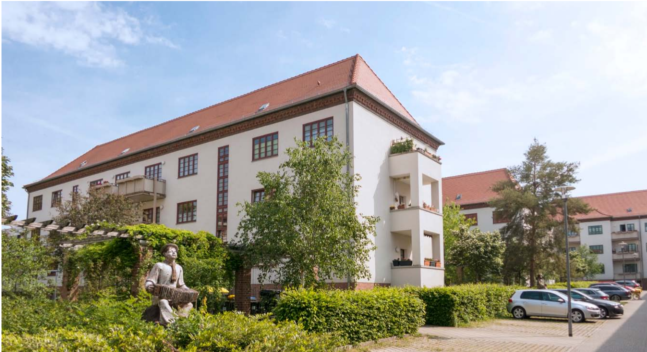
Der von Heinrich Faller erbaute Reilshof am Rande des Paulusviertels als gartenstadtartig aufgelockertes Ensemble ist ein Beispiel für den typischen Siedlungswohnungsbau der 1930er-Jahre. Im Vordergrund ist zudem der "Harmonikspieler" von Richard Horn zu sehen.
