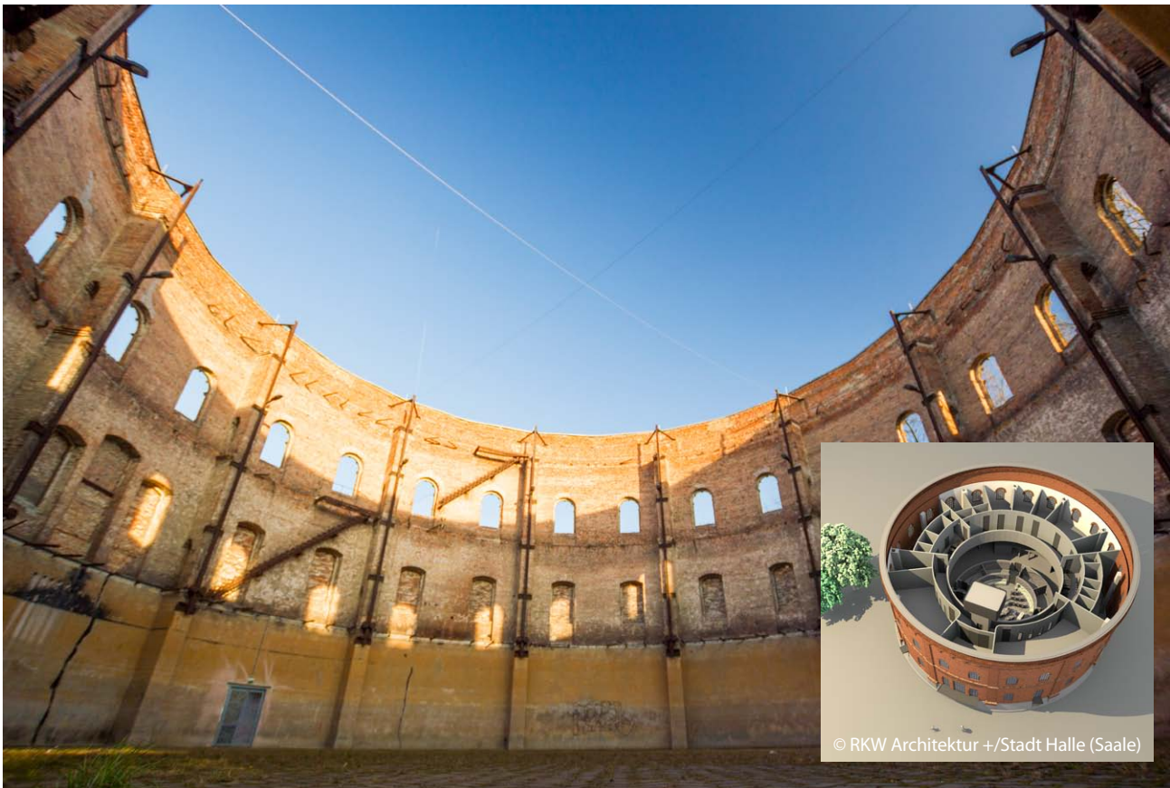
Derzeit noch eine leere Hülle – ab Mitte 2021 sollen im Gasometer unter anderem ein Café, Ausstellungs- und Seminarräume entstehen
